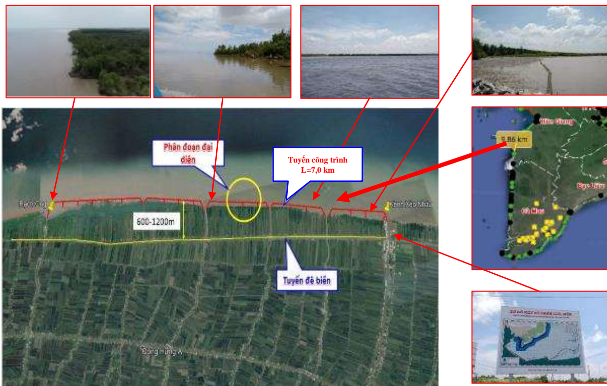
Hình 1.4: Vị trí tuyến kè khu vực Xẻo Nhàu, An Minh, Kiên Giang
