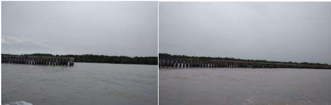
Hình 3.19: Công trình kè giảm sóng đang được hoàn thiện và kết nối với công trình kè của dự án (ảnh chụp tháng 8/2020)
